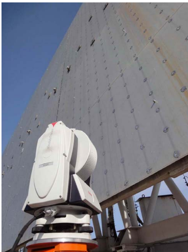
Рисунок 24 - Предварительная оценка состояния отражающей поверхности элемента плоского отражателя
