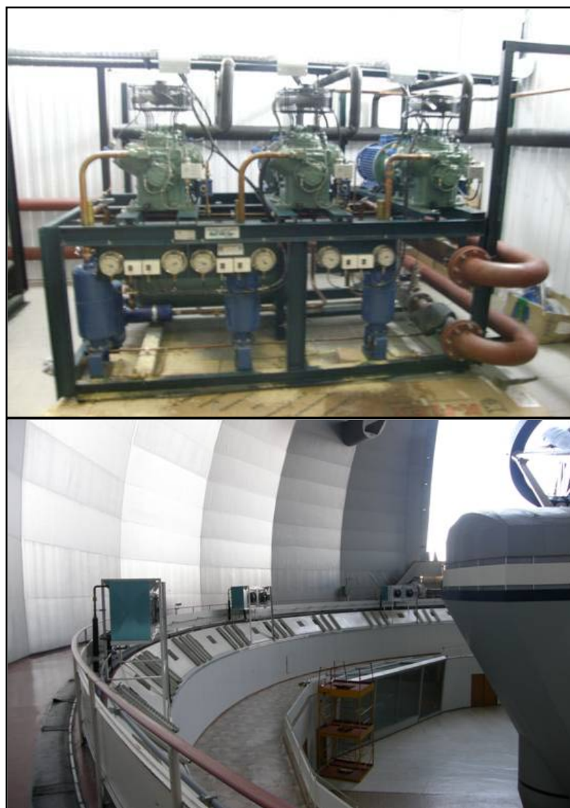
Рис. 1. Компрессорная станция системы охлаждения (вверху), воздухоохладительные приборы, установленные по периметру башни телескопа БТА (внизу).
