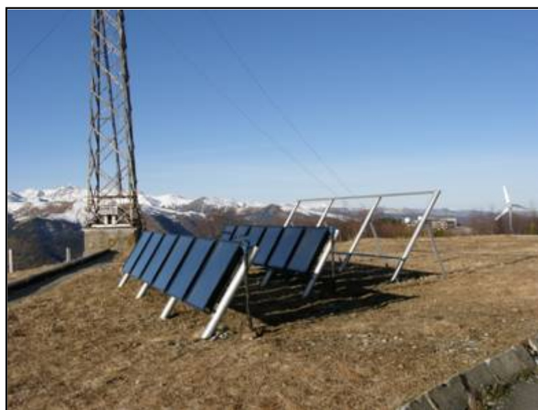
Рис. 4. Солнечная нагревательная установка, предназначенная для обогрева помещений башни телескопа БТА.
