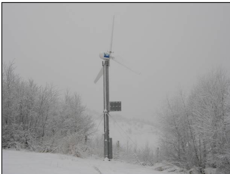
Рис. 3. Ветроэнергетическая установка ВЭУ-2.5, расположенная на Верхней научной площадке САО РАН.
