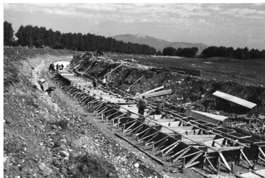
... и подготовка опалубки под заливку бетона. 1969 г.
