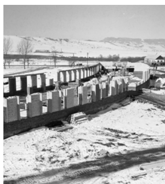
Строительство лабораторного корпуса
