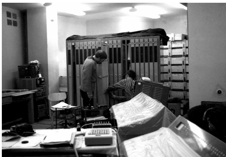
Монтаж ЭЦУМ – электронной цифровой управляющей машины телескопа
