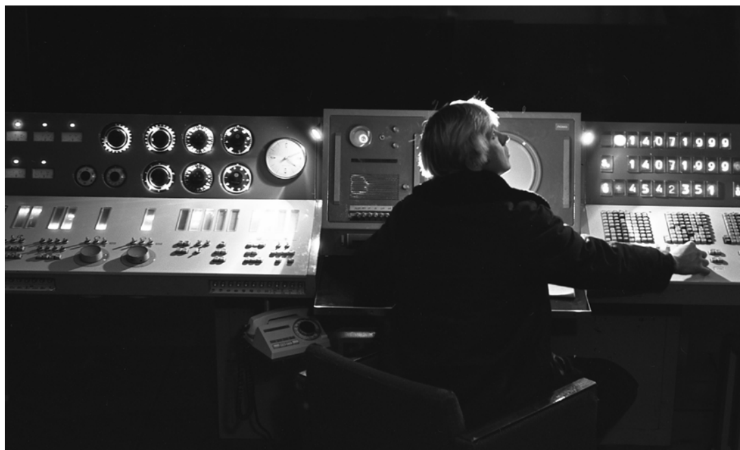
Центральный пульт управления во время наблюдений. 1975 г.
