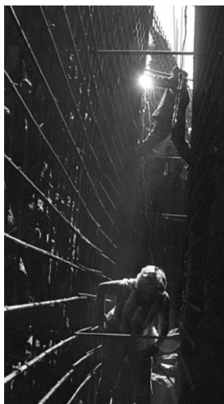
Арматурные работы под фундамент башни. Осень 1966 г.
