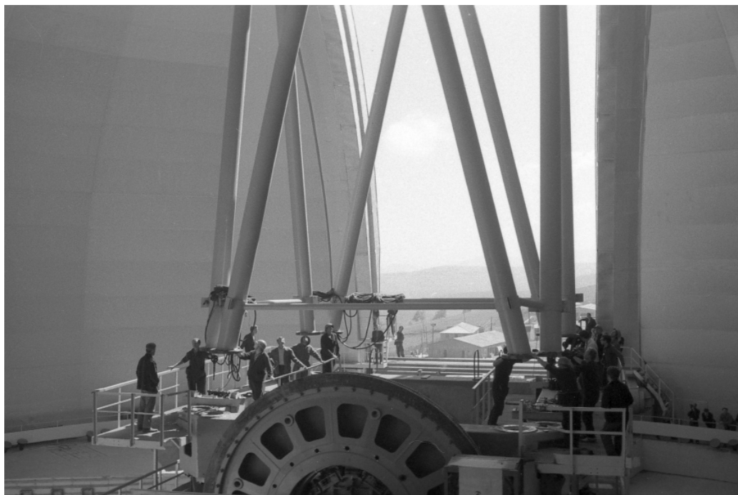
Соединение верхней и нижней частей трубы в единую конструкцию. Лето 1970 г.
