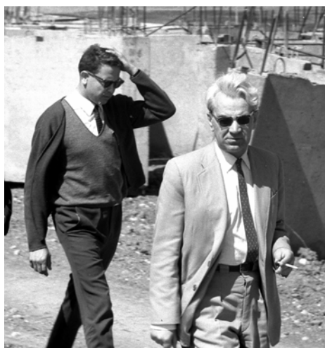
Осмотр стройки. М.В.Келдыша сопровождает директор СНО Ю.Е. Якунин. 17 июля 1969 г.
