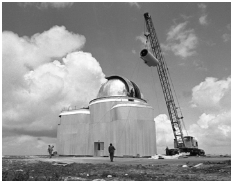
Строительство 1-метрового телескопа. 1988 г.
