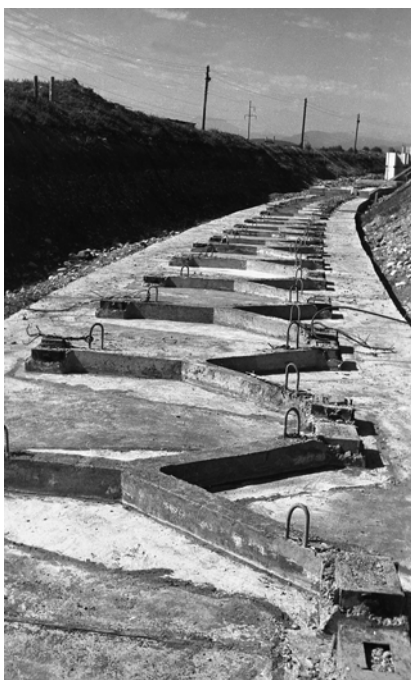
Фундаменты опор элементов главного зеркала РАТАНа...
