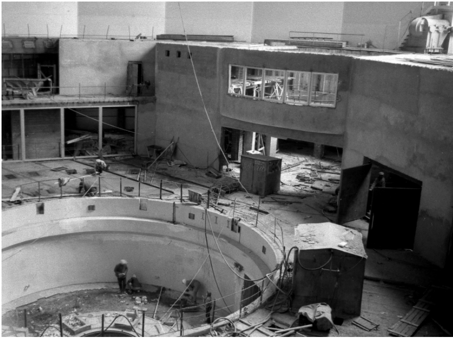
1969 год. Обустройство подкупольного зала...
