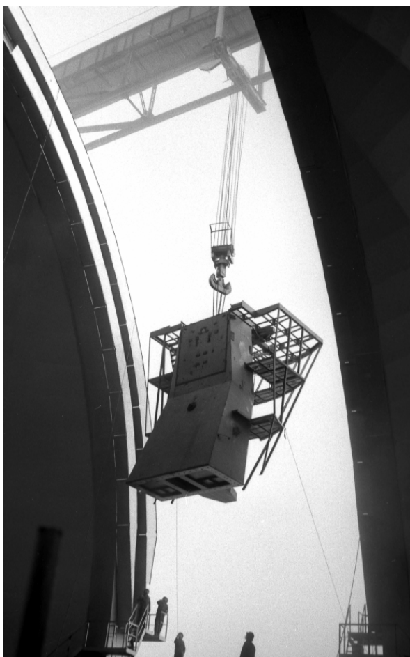
Монтаж стоек БТА. Лето 1970 г.
