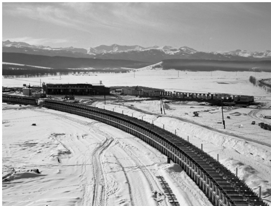
Сборка металлоконструкций опор главного зеркала
