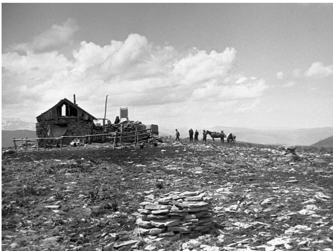
Так выглядел склон г. Семиродники до начала строительства телескопа в июне 1965 г.
