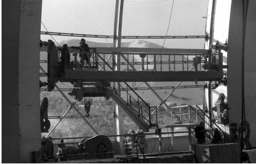
Монтажники «Южстальконструкции» ведут монтаж механизмов забрала башни БТА. Декабрь-январь 1970 г.
