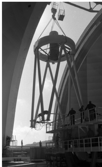
Транспортировка верхней части трубы и стакана пер- вичного фокуса
