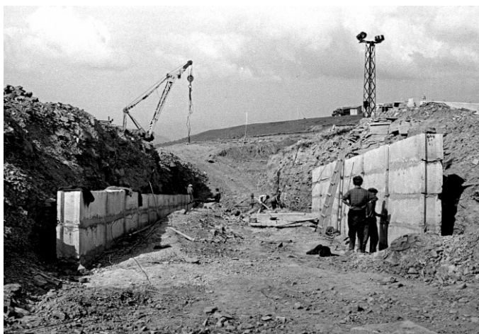
Начало строительства техблока. 1966 г.
