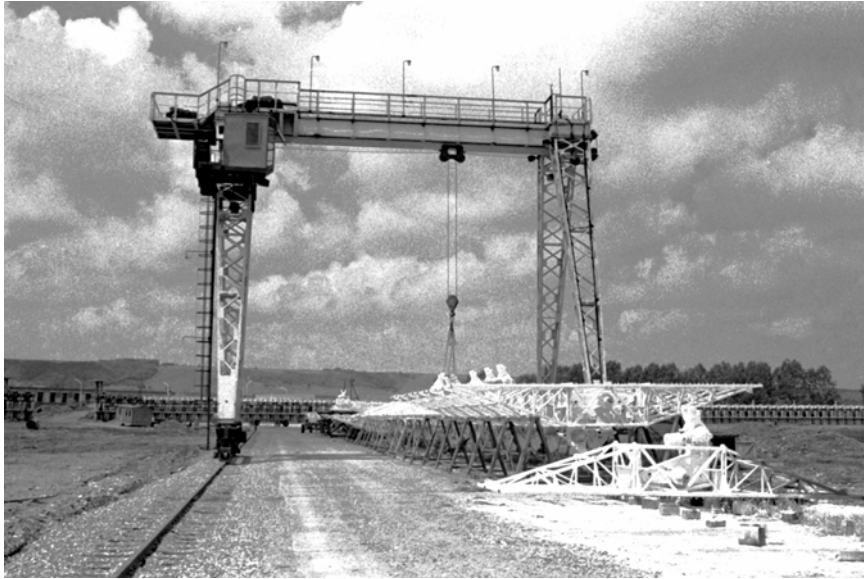
Сборка плоского зеркала радиотелескопа
