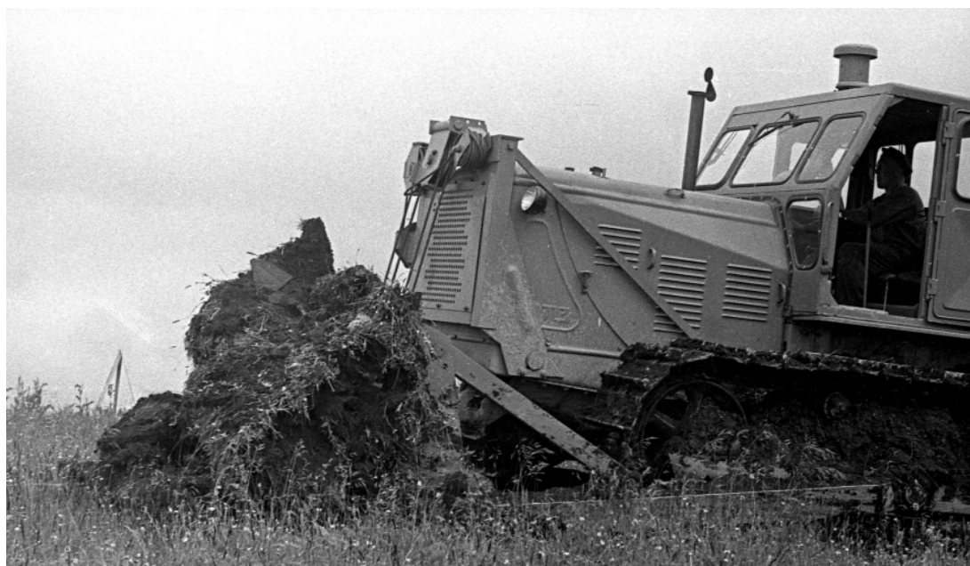
День начала строительства на Верхней площадке САО – 11 июля 1965 г.
