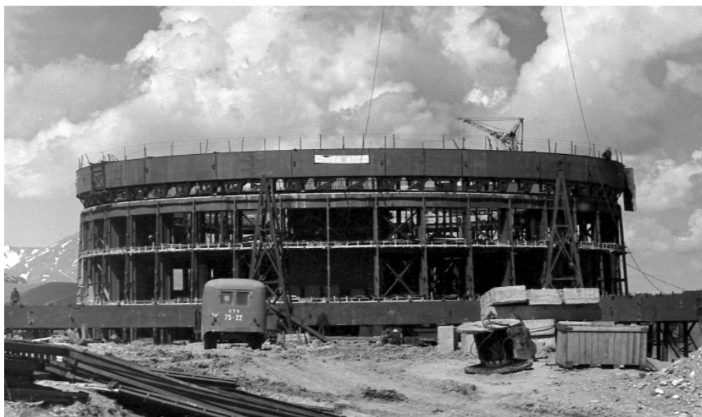
Монтаж каркаса помещений башни. Работы ведет Ростовское управление треста «Южстальконструкция», 1967 г.
