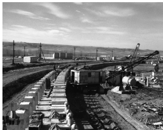
... и установка этих опор. 1969 г.
