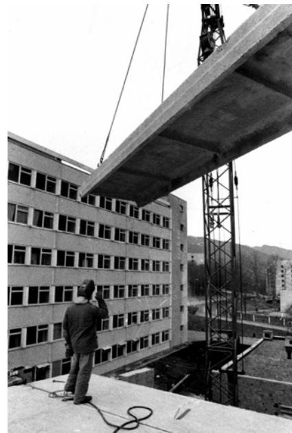
Строительство лабораторного корпуса и Большого конференц-зала
